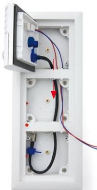
4. Setzen Sie das Modul zunächst mit der **rechten Seite im Rahmen ein** und drücken sie es dann auf der **linken Seite fest**, bis es mit einem hörbaren **Klick** einrastet.
