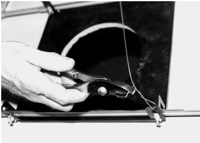
Bild 9.5: Sichern der Halterung
